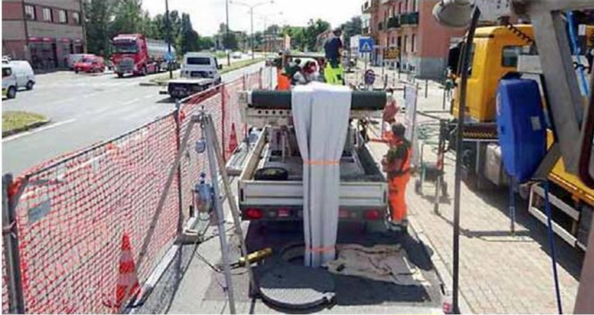
Gli addetti della Rotech Srl al lavoro sulle condotte idriche di Milano
