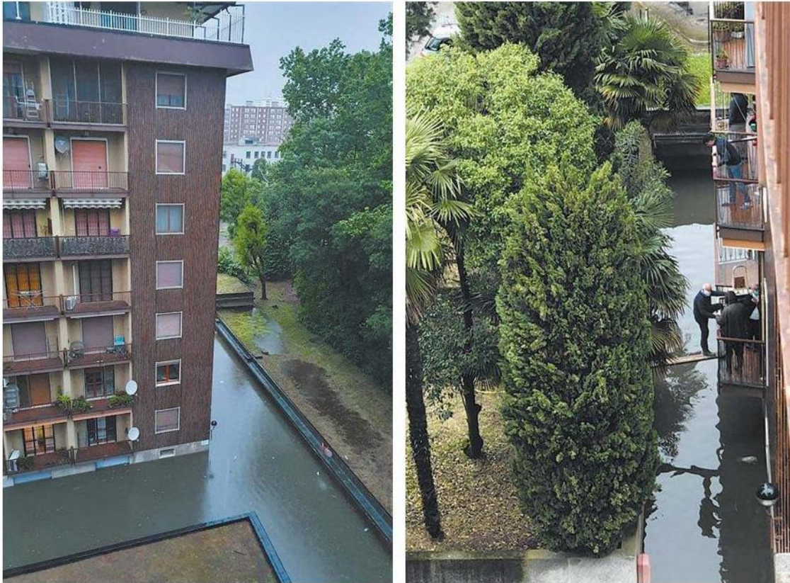
A sinistra, il cortile box trasformato in piscina; a destra, una delle passerelle approntate per scavalcare il "fossato"
