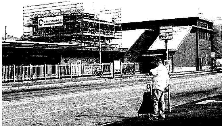
LAVORI Alla stazione di Cologno Nord si distinguono le impalcature per realizzare l'ascensore e la passerella di vetro sopra le pensiline
