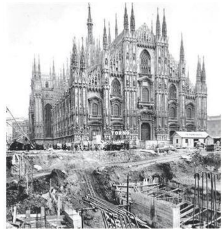
Il cantiere della M1 in piazza Duomo
