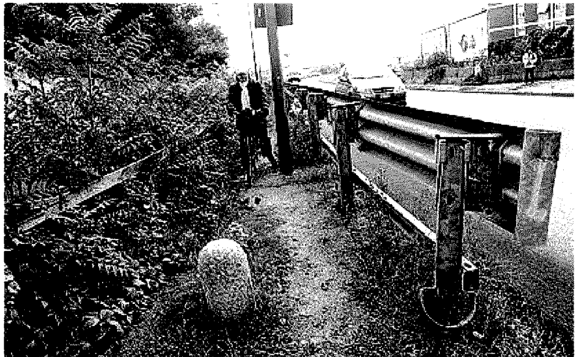
GIMKANA Il guard-rail autostradale invita pedoni e bici a passare dietro
