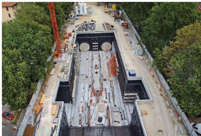
I cantieri della MM 4 in Viale Argonne
