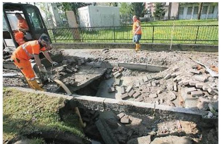
PROBLEMI In alto l'acqua in zona Mecenate dopo il guasto; sopra i lavori di ripristino (Fotogramma)
