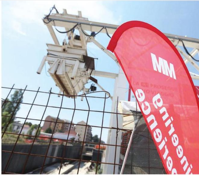
Riparte il cantiere della M1
