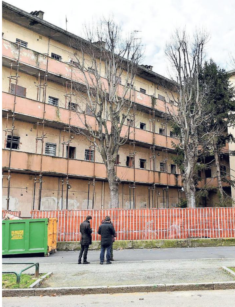
Uno dei palazzi popolari al Lorenteggio che dovrà essere abbattuto
