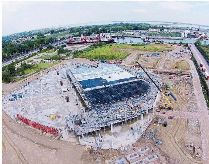
Una foto del cantiere della piastra per l'Expo di Milano: scagionati impresa Mantovani e Baita (in alto)
