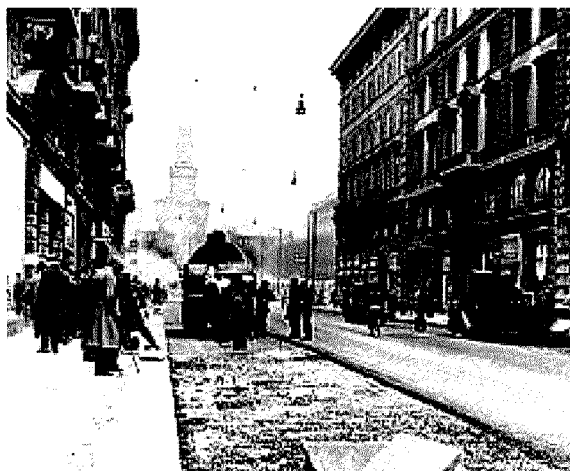
Album Via Dante e Piazza Duomo durante i lavori della Linea Uno, 1958-1962. Le foto sono conservate alla Biblioteca di Mendrisio
