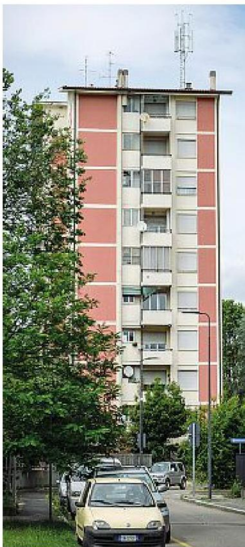
Il ripetitore L'antenna in via Pastonchi 2 (foto Corner)
