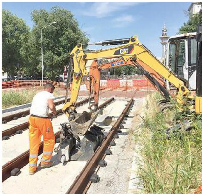
DOPO ANNI DI DISAGI I lavori per prolungare il 15 di 5 fermate sono finalmente in dirittura d'arrivo con la posa della rete elettrica
