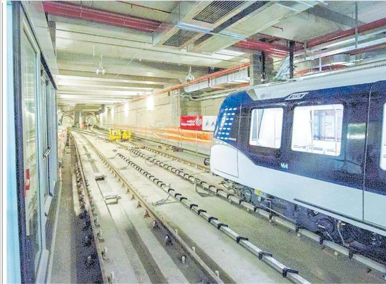
▲ Linea Blu Il tunnel della M4 con un treno già sui binari: l'apertura avverrà a segmenti tra il 2021 e il 2023
