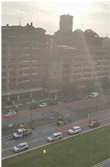
Ruspe al lavoro in via Adriano dopo le opere di bonifica
