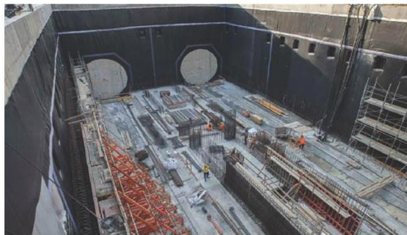
Tunnel Sopra, i cantieri per la costruzione della linea 4 della metro (Archivio)
