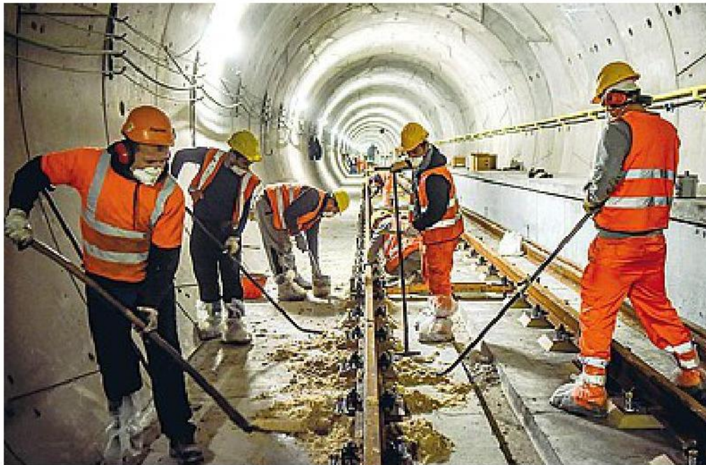
In galleria Operai nel tunnel del nuovo tratto della metropolitana 4 Linate-Forlanini (foto Furlan/Lapresse)
