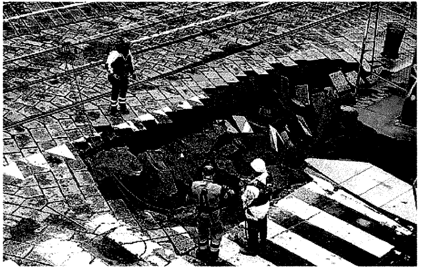
CHOC La voragine che si aprì in corso di Porta Romana il 26 luglio di due anni fa
