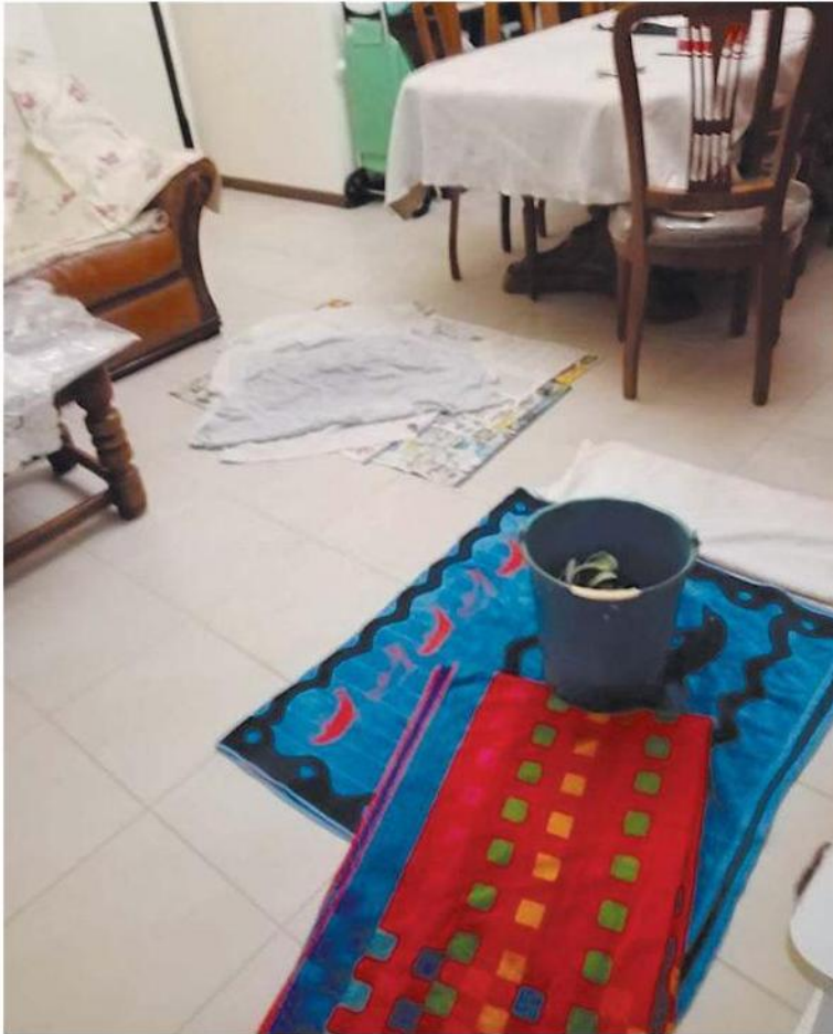
Secchi e asciugamani usati per raccogliere e asciugare le infiltrazioni d'acqua
