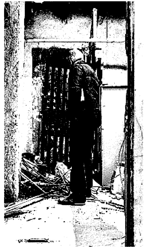
I luoghi «Tane», degrado e abbandono in via Giambellino
