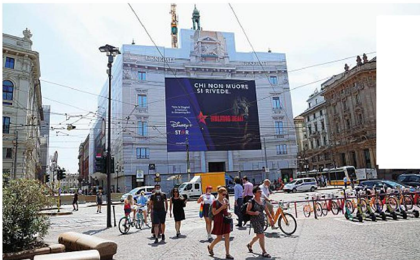
Palazzo Venezia La storica sede delle Generali in piazza Cordusio realizzata a cavallo tra 800 e 900 su disegno di Luca Beltrami. In restauro, dal 2023 ospiterà l'hotel (Piaggese)
