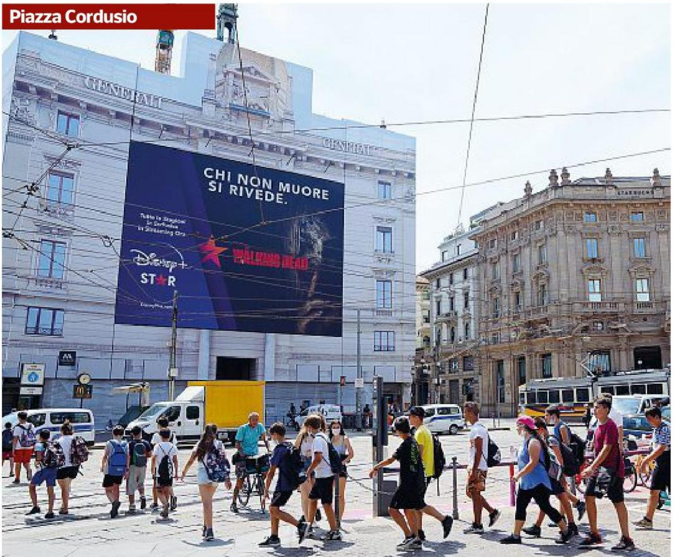
Il cantiere In piazza Cordusio sono in corso i lavori per la trasformazione di «Palazzo Venezia», storica sede delle Generali nel centro di Milano, in hotel di lusso (Piaggese)
