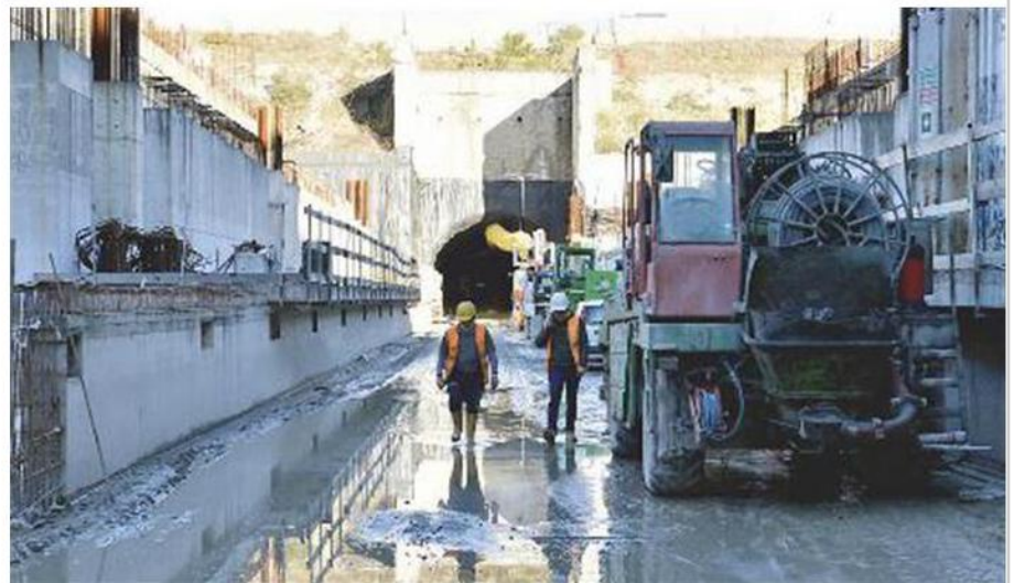
L'area del cantiere che vuol portare la linea rossa del metrò fino a Sesto resta tuttora una ferita aperta
