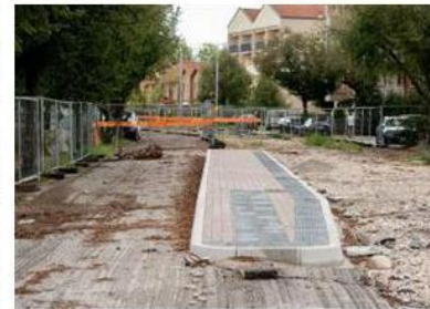
Uno dei cantieri per la filovia rimasti aperti, in via Caperle
