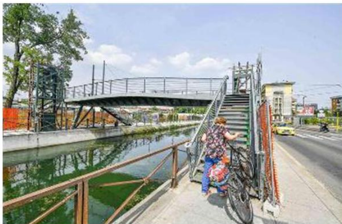
In ritardo l'installazione degli ascensori sul ponte in piazzale Negrelli-via Parenzo
