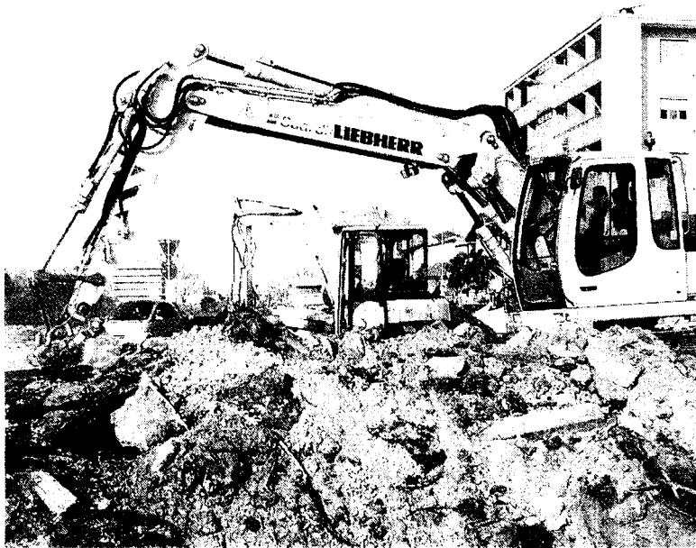
INTERVENTO Ruspe all'opera per predisporre la posa dei binari (Mdf)
