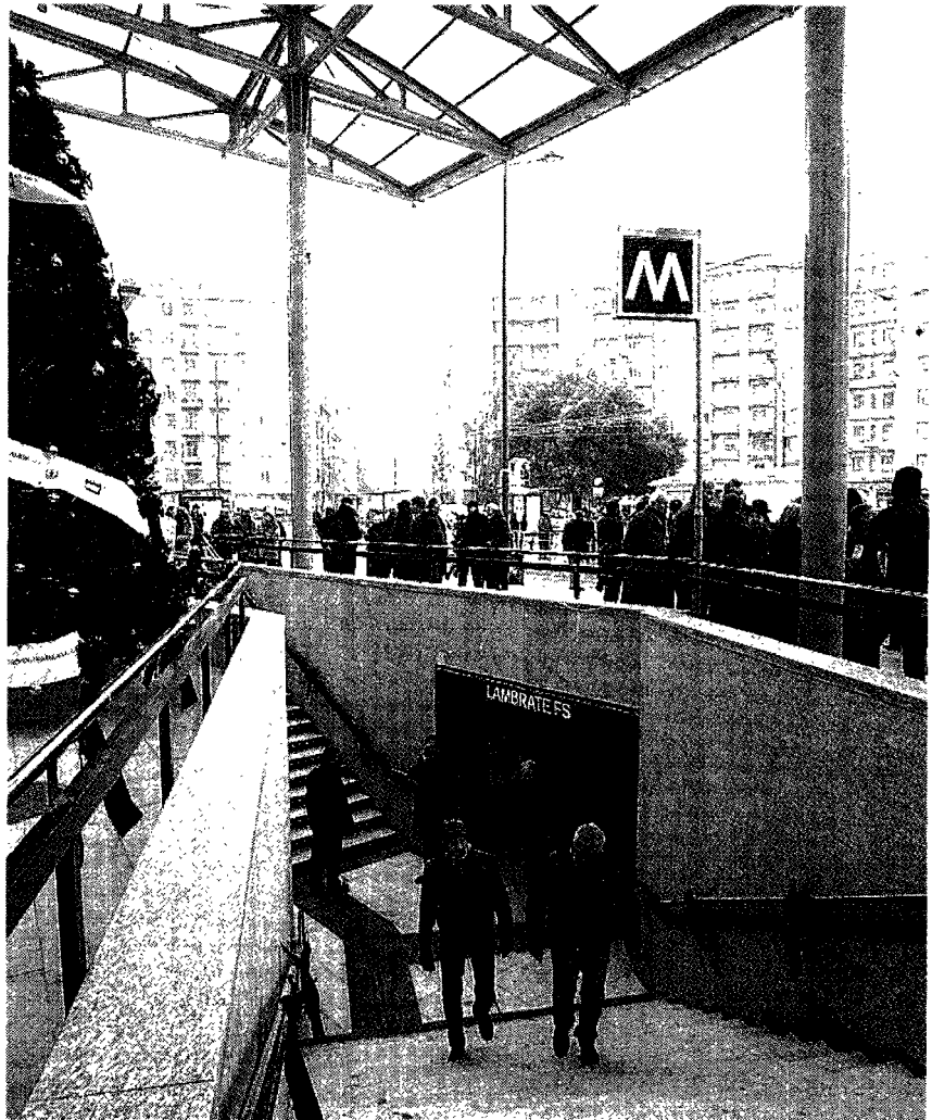
Pensilina La nuova struttura in metallo policarbonato, con accesso diretto alla metro
